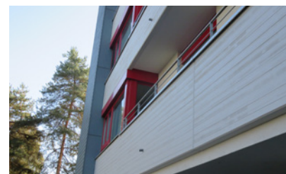
Vergleich der Balkonbrüstungen vor und nach der Erneuerung
