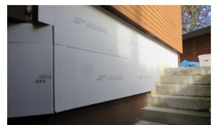
Anbringung von neuen Isolationsplatten
