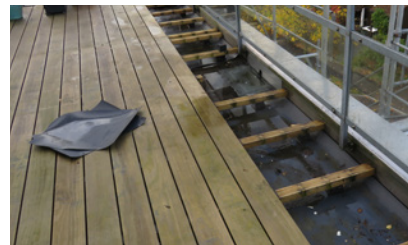
Montage eines zusätzlichen Ablaufs
